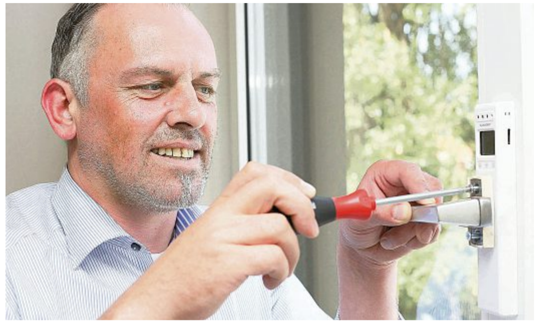
Georg Meyer bringt einen Klimagriff zwischen Fenstergriff und -rahmen an.
